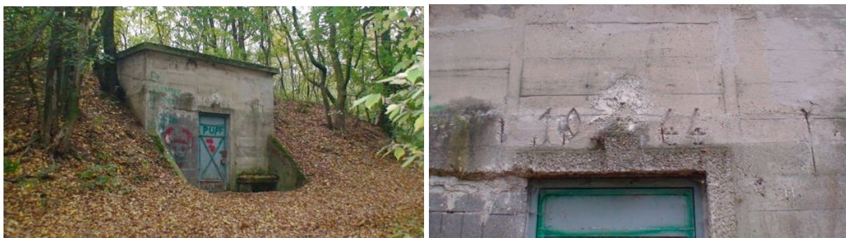
Le réservoir presque terminé mais jamais mis en service...la date 1944 est gravée au dessus de la porte
